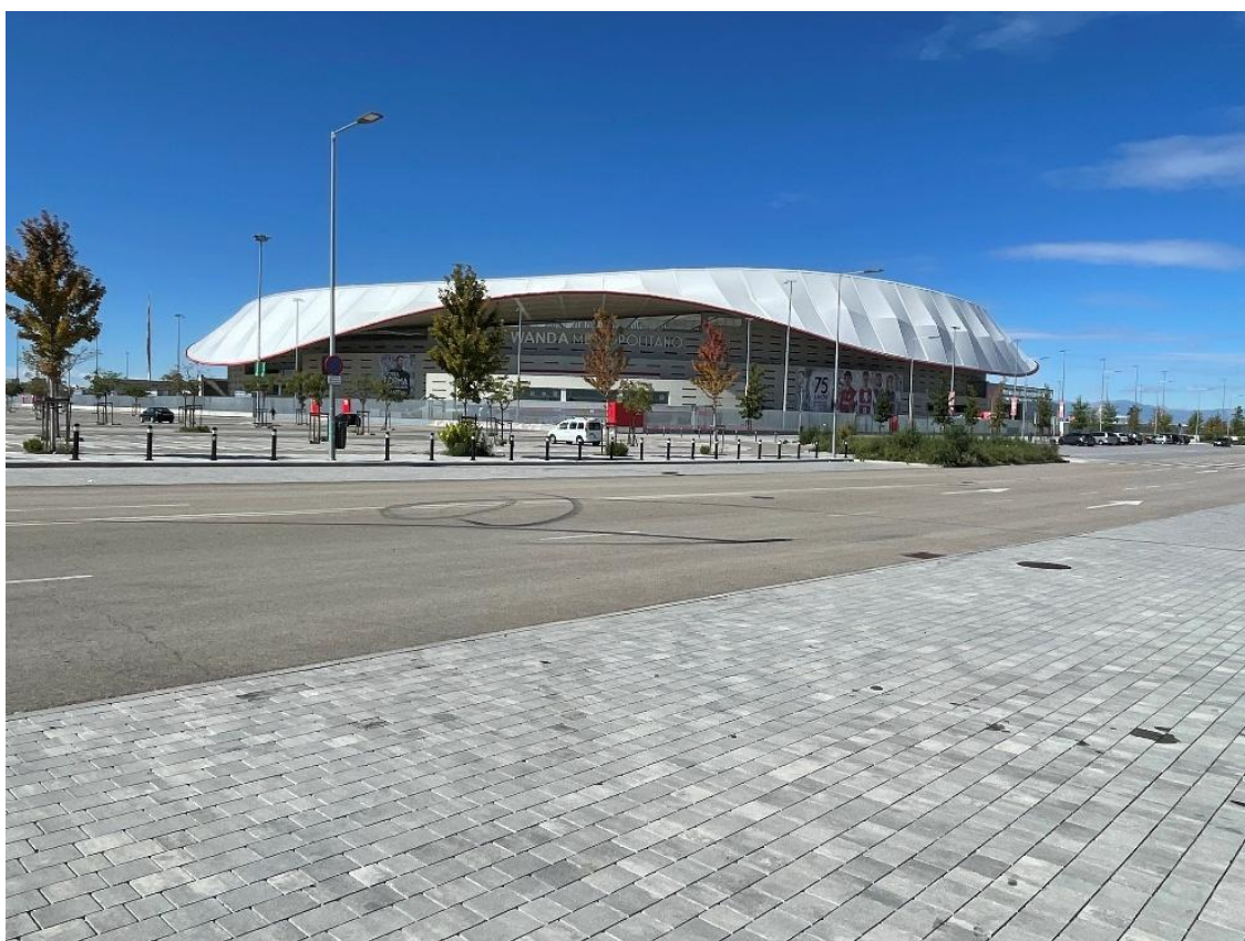
Figura 11. Pavimento permeable por junta, en el estadio Metropolitano de Madrid.
