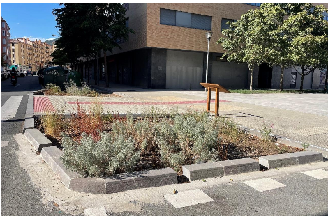
Figura 10. Área de biorretención, en el barrio de la Rochapea, Pamplona.
