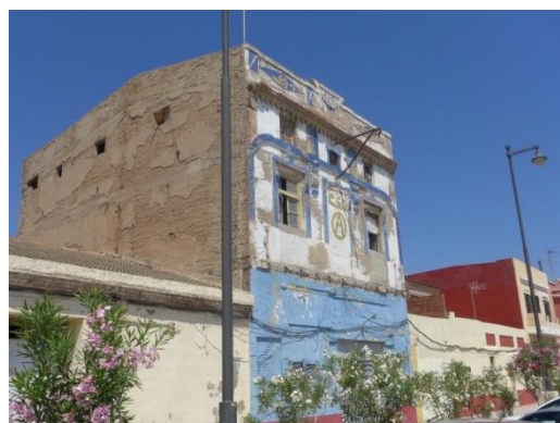
Edificación al N de la Fábrica de Hielo
