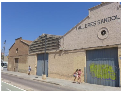
Fábrica de Hielo y naves adyacentes
