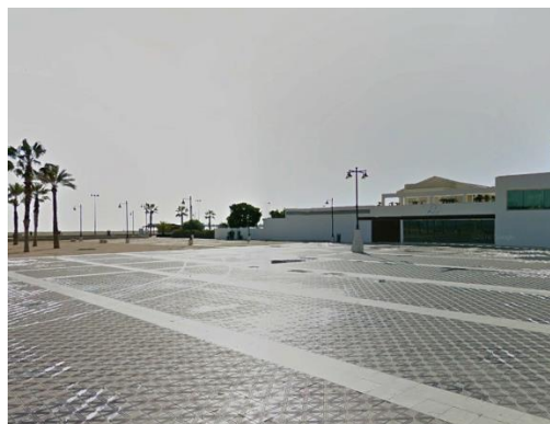
Explanada en Paseo Marítimo
