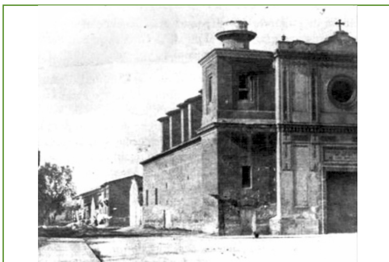
Arriba, vista del campanario desde c/ Comte d'Almenara. Abajo, dos fotografías de la primitiva iglesia (1880) donde todavía se apreciaba el faro demolido en 1925 (Col. Díaz Prosper y Rieta López)
