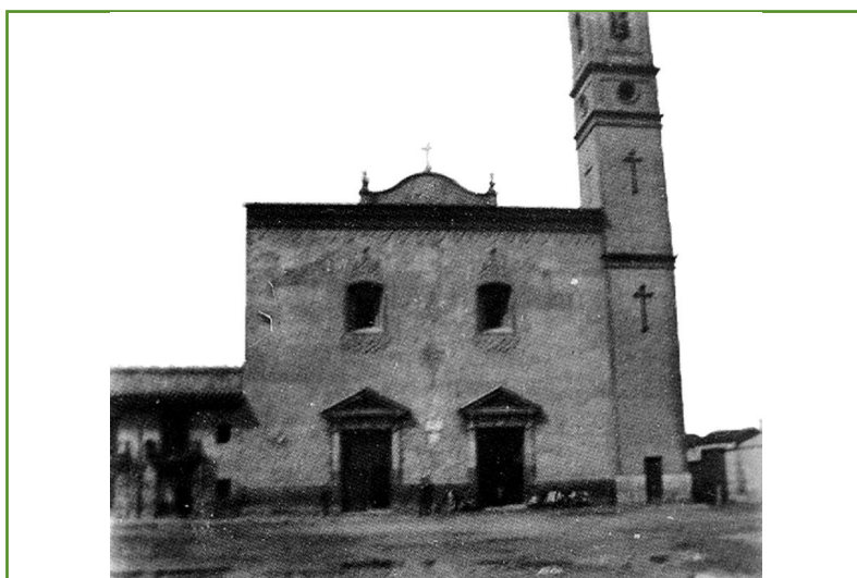
Arriba, detalle de una de las puertas de la fachada principal. Abajo, fotografías de la antigua ermita del Rosario y de la iglesia anterior a las reformas del siglo XX (Fuente: www.jdiezarnal.com ).
