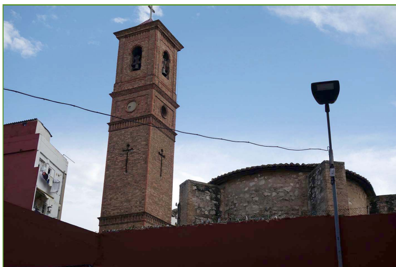
Arriba, detalles de diferentes componentes de la fachada principal. Sobre estas líneas, vistas del campanario desde c/ Maestra Pilar Hernández
