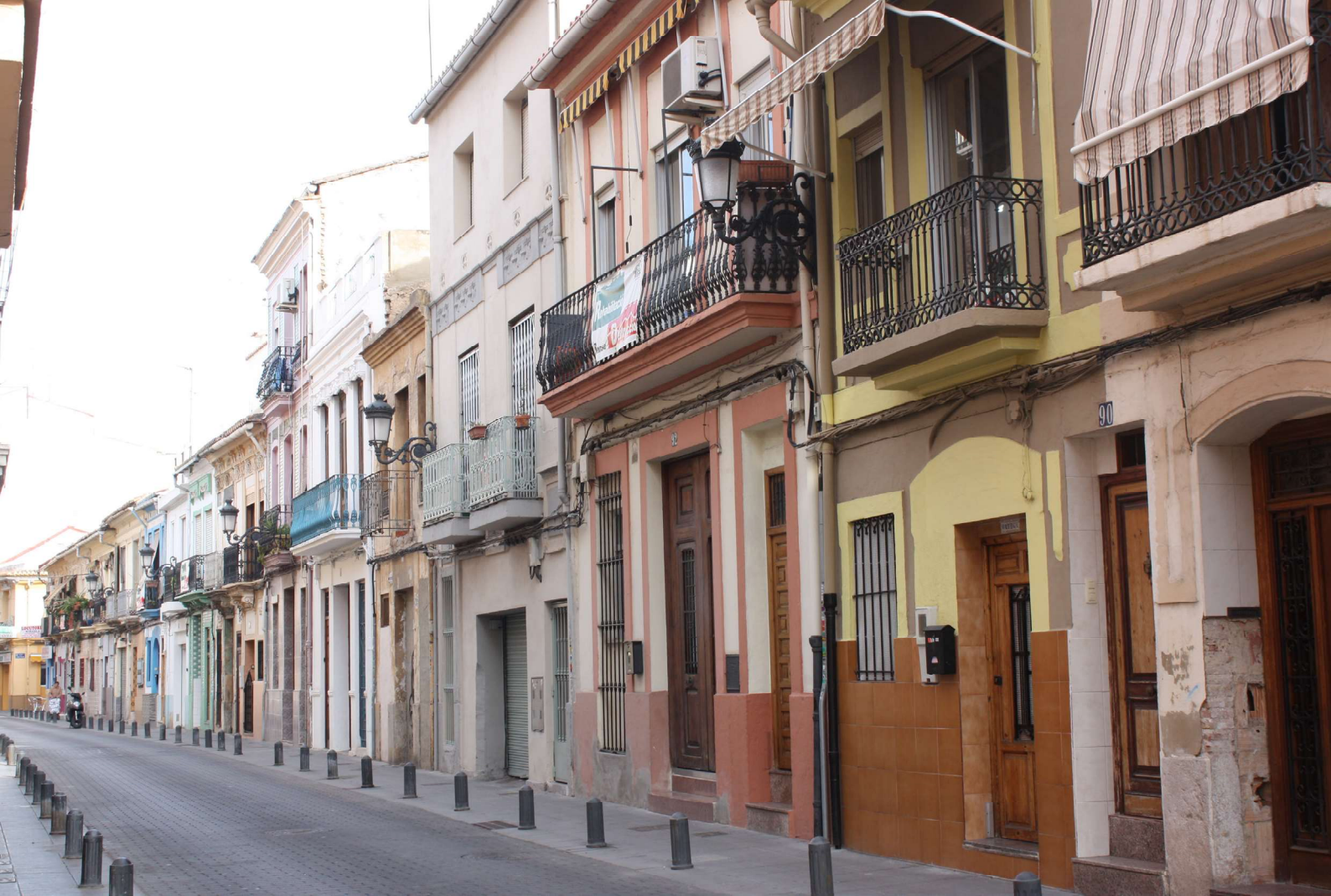
Figura 26. Vista calle Rosario. (Pastor, R. 2011)
