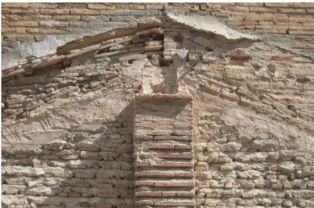
En alguna ocasión, en lugar de fábrica de ladrillo se utilizan unos bloques de hormigón compuestos de arena de la playa (posee incrustaciones de conchas marinas), áridos y cemento que se realizaban con unos moldes de madera con la misma técnica del adobe; se recibían con mortero de cemento y arena y se revestían con mortero de cemento.
