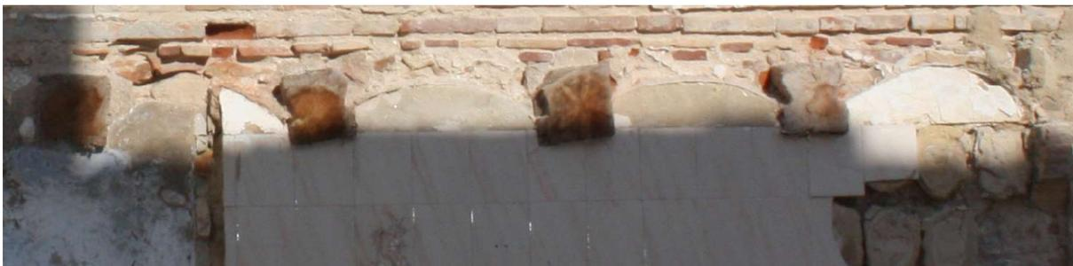
Figura 102. Detalle de vigüeta en la que se han practicado unas muescas para el apoyo de la bovedilla. (Pastor, R. 2010)
