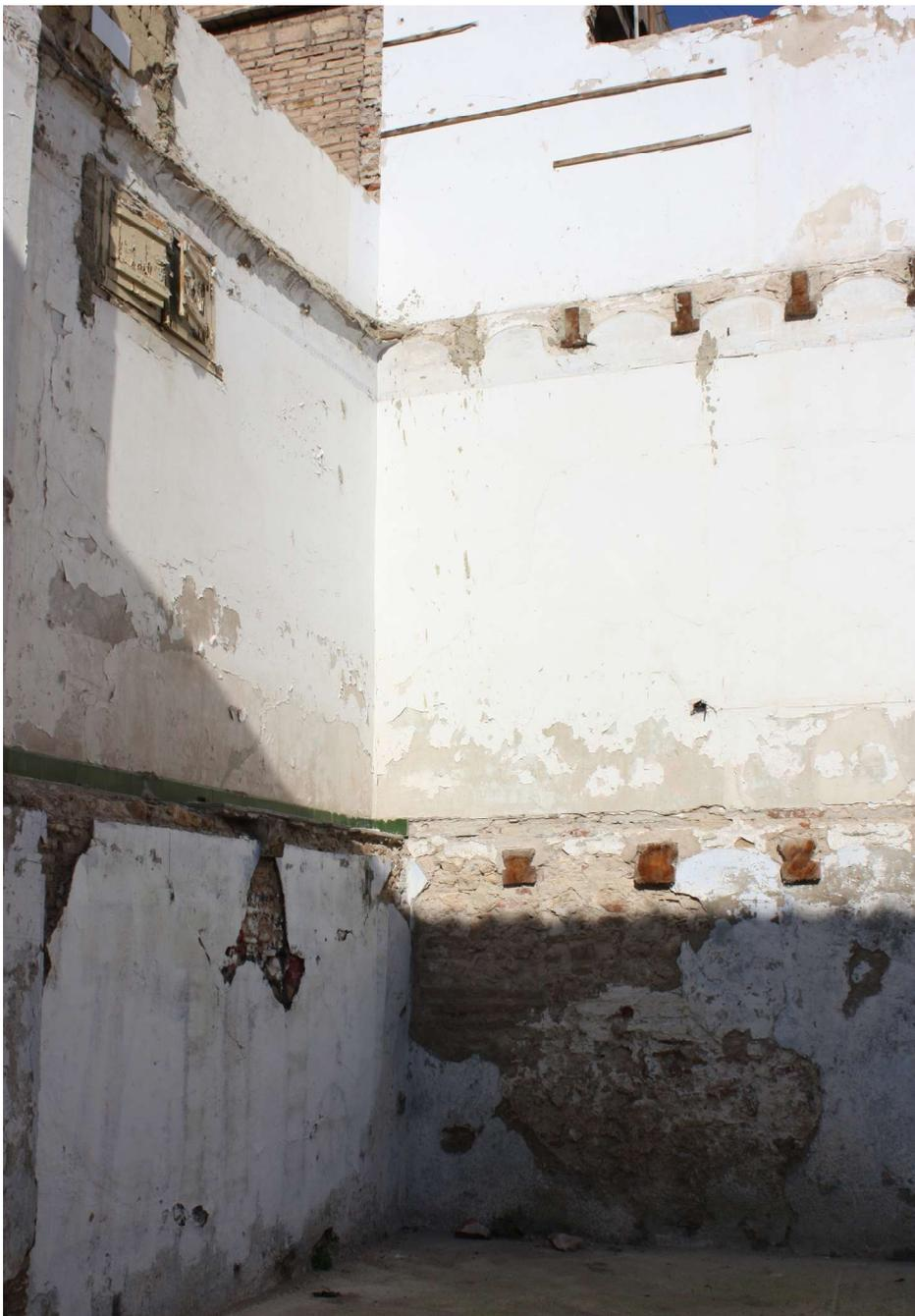
Figura 101. Vista de dos tipos de apoyo de bovedilla sobre vigüeta de madera en derribo de edificio. (Pastor, R. 2010)
