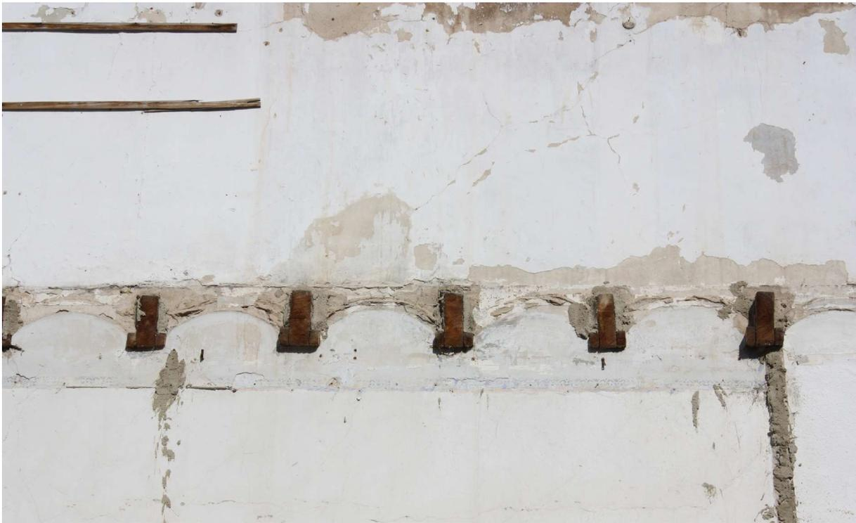
Figura 103. Apoyo de la bovedilla sobre dos listones laterales clavados a la vigueta. Derribo de edificio en calle Escalante. (Pastor, R. 2010)
