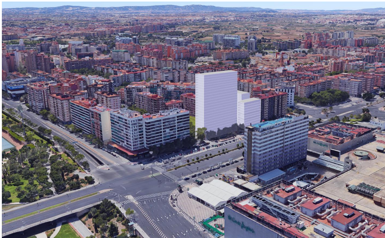
Alternativa-3. Vista hacia el Oeste.
