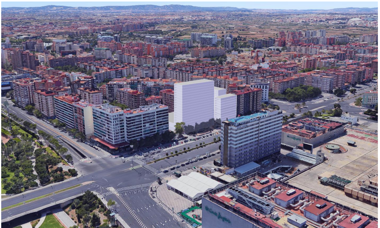
Alternativa-2. Vista hacia el Oeste.
