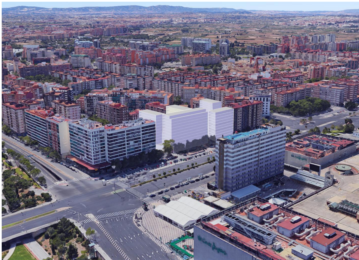
Alternativa-1 . Vista hacia el Oeste.
