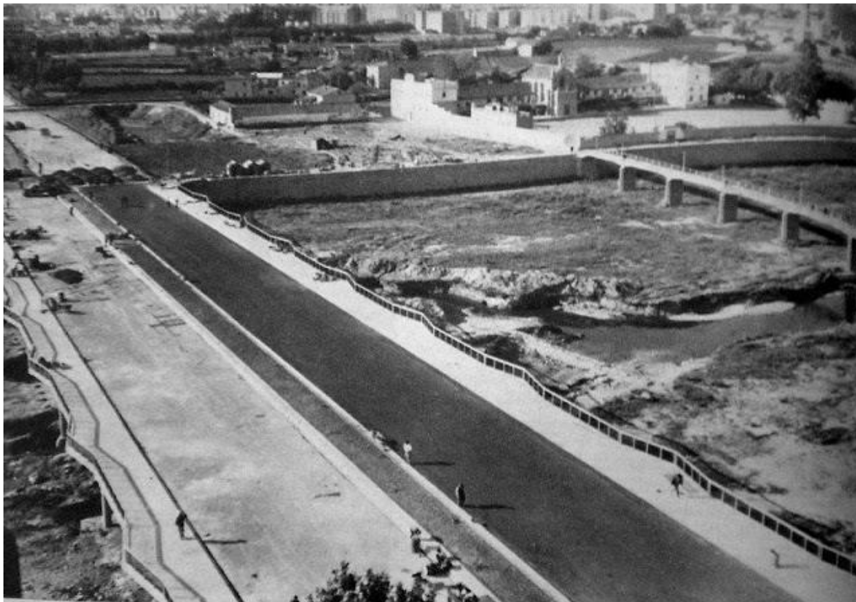
1964. Puente de Ademuz (actual Pont de les Glòries Valencianes)
