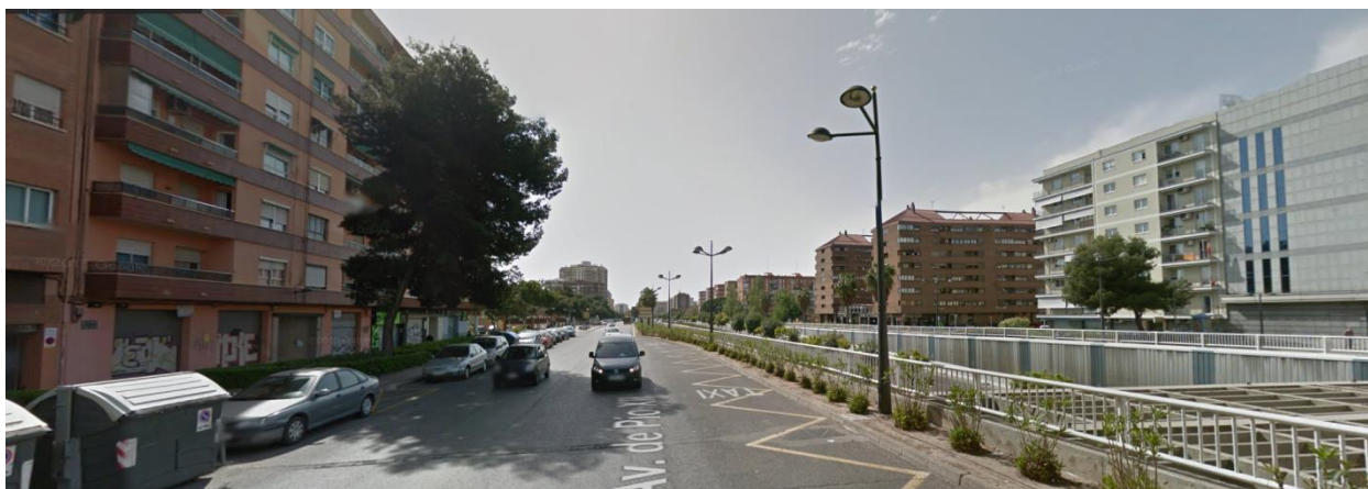
PO-9. Avenida Pío XII a la altura paso subterráneo con Avda. General Avilés
