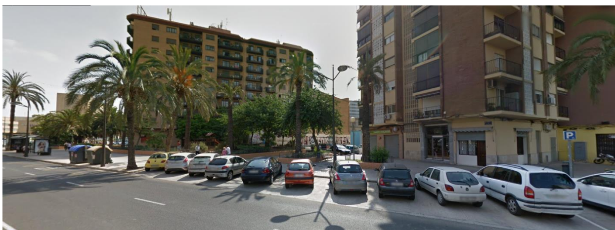
PO-5. Avenida Campanar hacia esquina Pío XII
