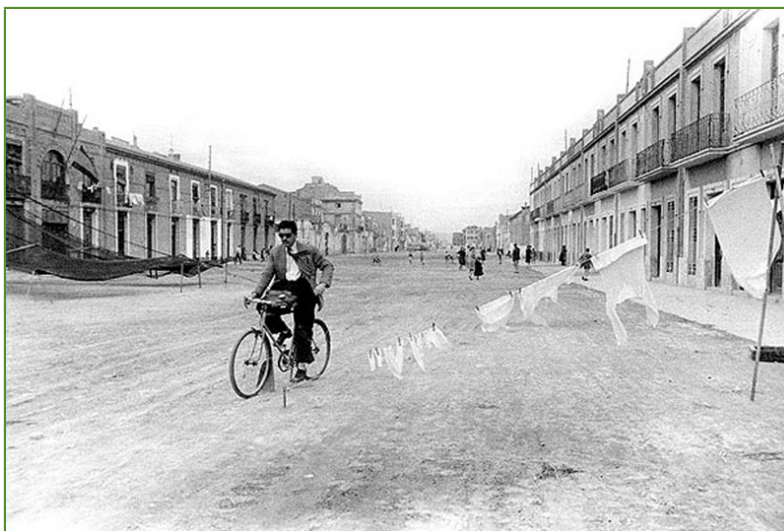
Arriba, fotografía aérea del Cabanyal-Canyamelar, 1920-1930. En el centro, despliegue de infraestructura pesquera en la playa. Abajo, entorno de la Lonja de Pescadores de la Marina Auxiliante y el grupo de viviendas de Pavía, Robert Frank, años 50.
