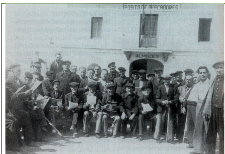
Fotografías antiguas de la Casa dels Bous en funcionamiento (Fuente: Sanchis Pallarés, 1998; Vicente Gallart)
