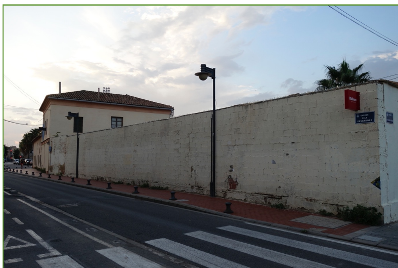
Arriba, vistas del lateral sur del edificio y de la fachada de la nave adosada al cuerpo principal. Abajo, vista sur del muro perimetral del patio (2018).
