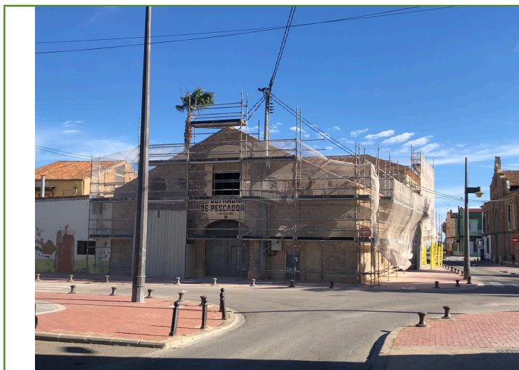
Arriba, detalle de las cabezas de bueyes del balcón de la fachada principal. Abajo, estado del edificio durante las obras de rehabilitación (diciembre 2021).
