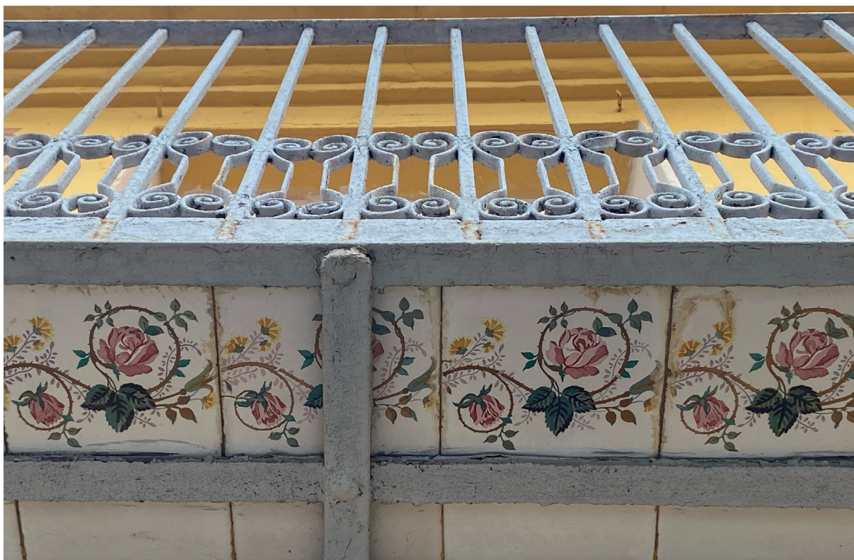
Figura 127. Balcón con estructura en jaula y sotabalcón cerámico. Calle Jose Benlliure 273 . (Pastor, R. 2022)
