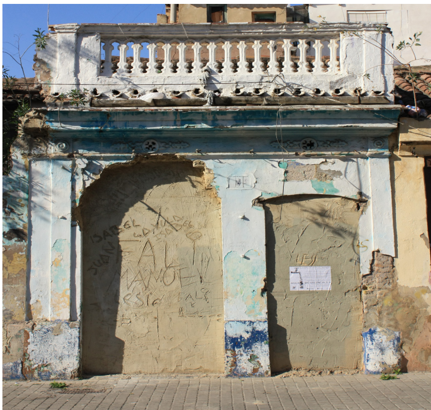
Figura 119. Antepecho de balaustres. Calle del Progreso. (Pastor, R. 2011)
