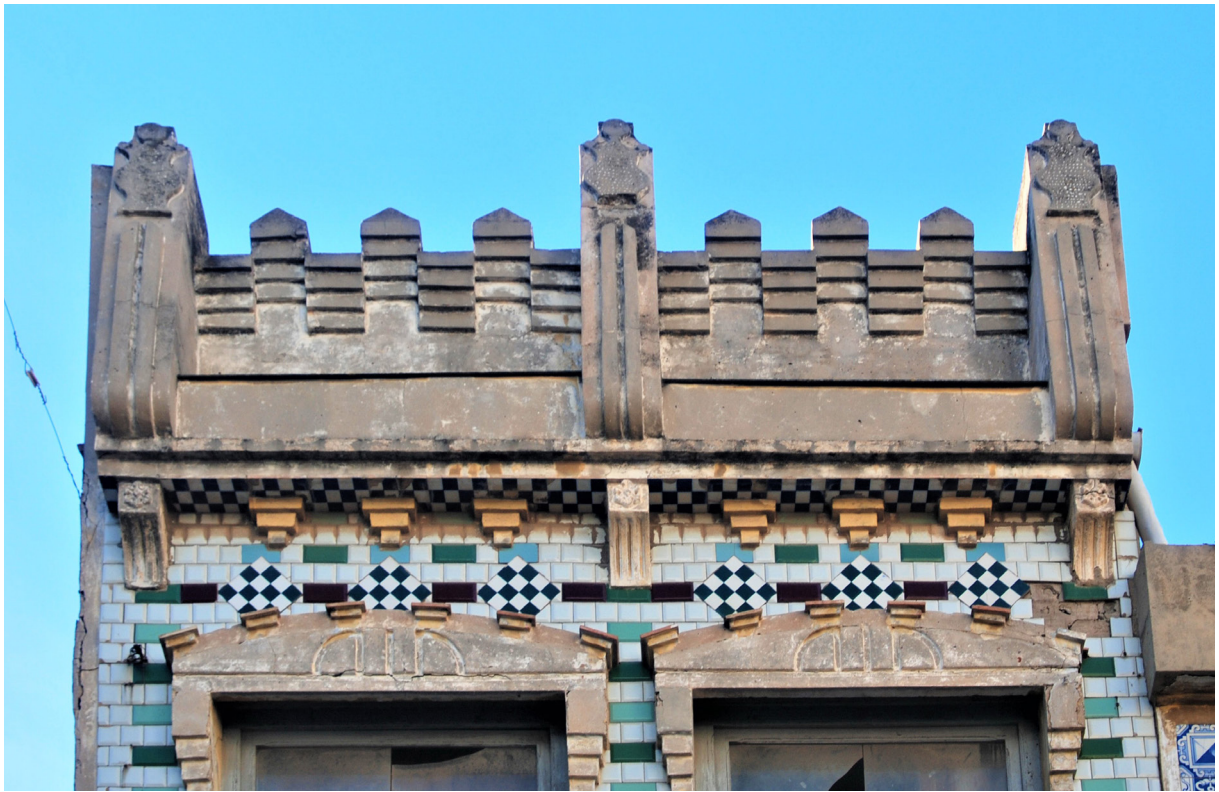
Figura 121. Antepecho de piedra artificial a base de cemento con formas geométricas. Calle Barraca. (Pastor, R. 2022)
