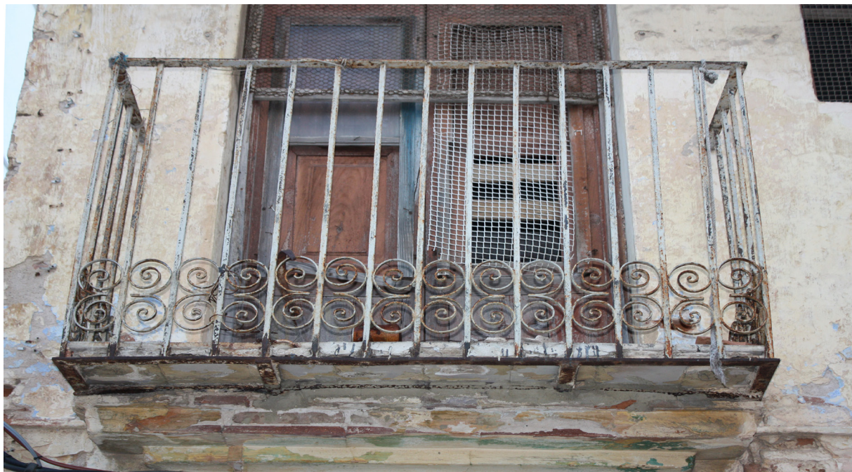
Figura 131. Balcón con estructura en jaula y sotabalcón cerámico. Calle Padre Luis Navarro (Pastor, R. 2011)
