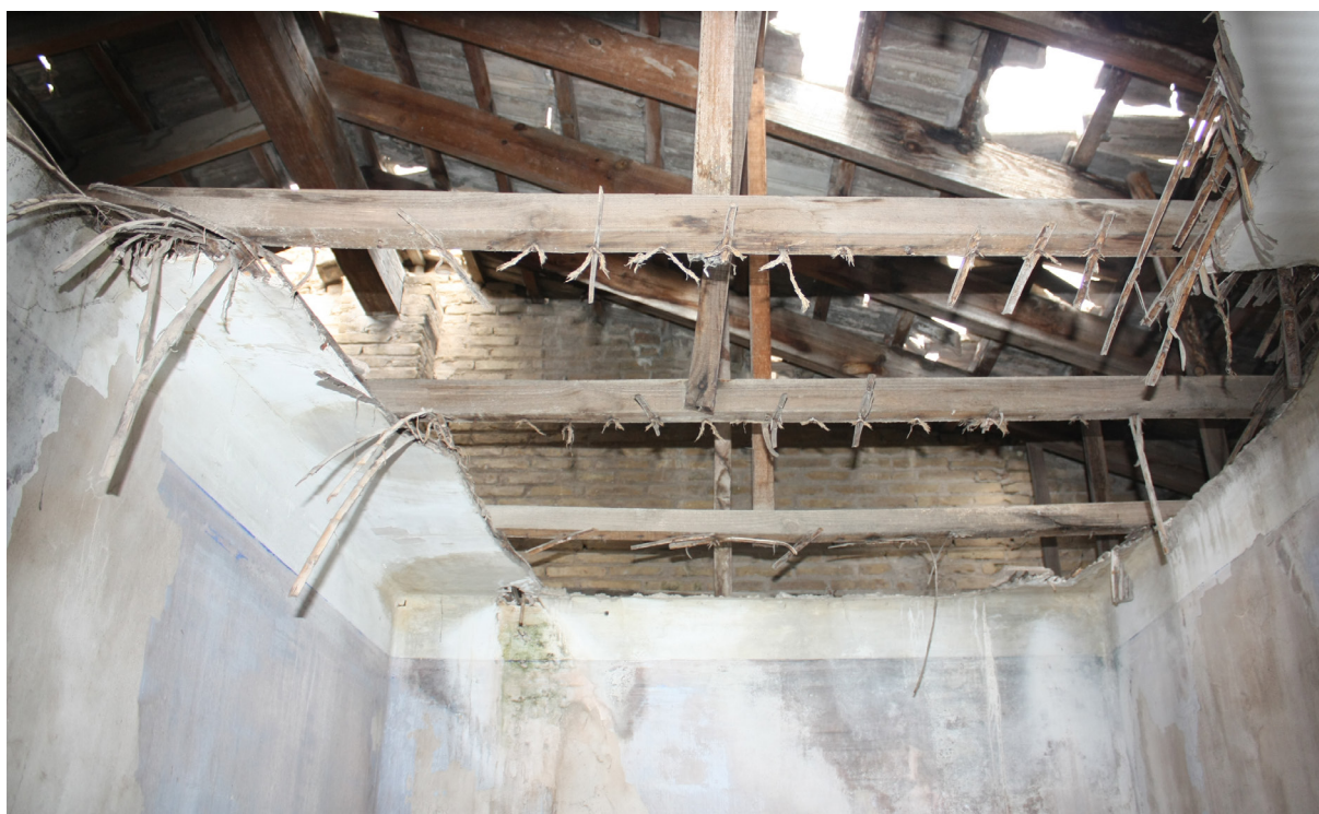
Figura 110. Cubierta sobre hoja de rasilla en El Cabanyal. (Pastor, R. 2009)
