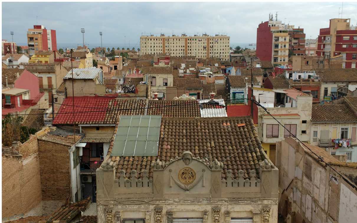
Figura 125. Remate de fachada en calle Escalante. (Pastor, R. 2015)
