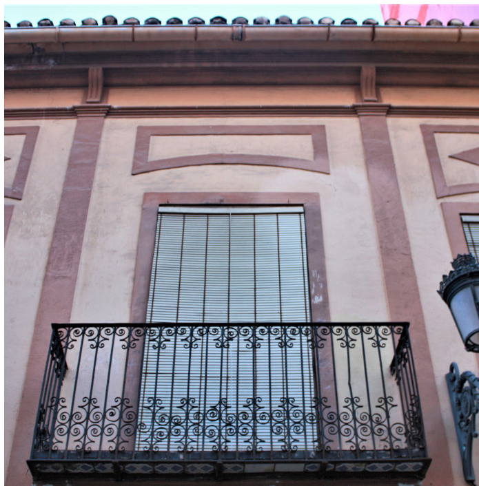
Figura 132.1. Balcón con estructura en jaula y sotabalcón cerámico José Benlliure 50. (Pastor, R. 2022)
