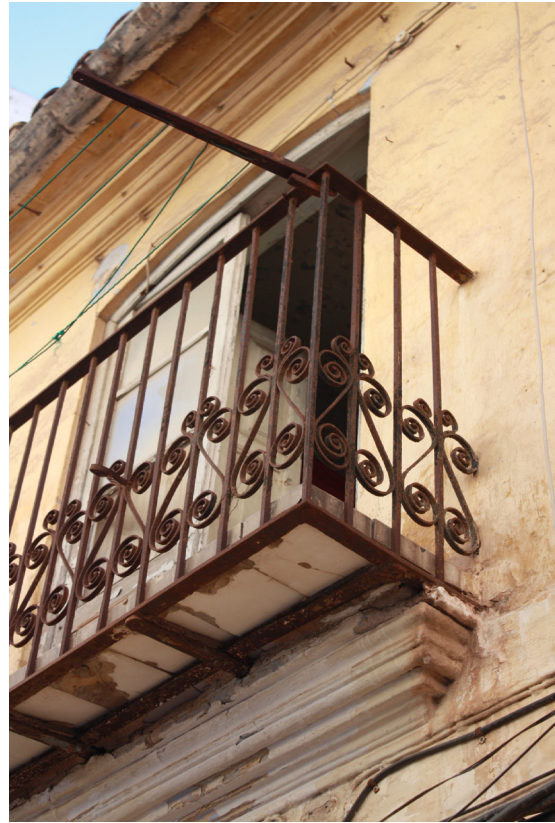
Figura 130. Balcón con estructura en jaula y sotabalcón cerámico. Calle Padre Luis Navarro. (Pastor, R. 2022)
