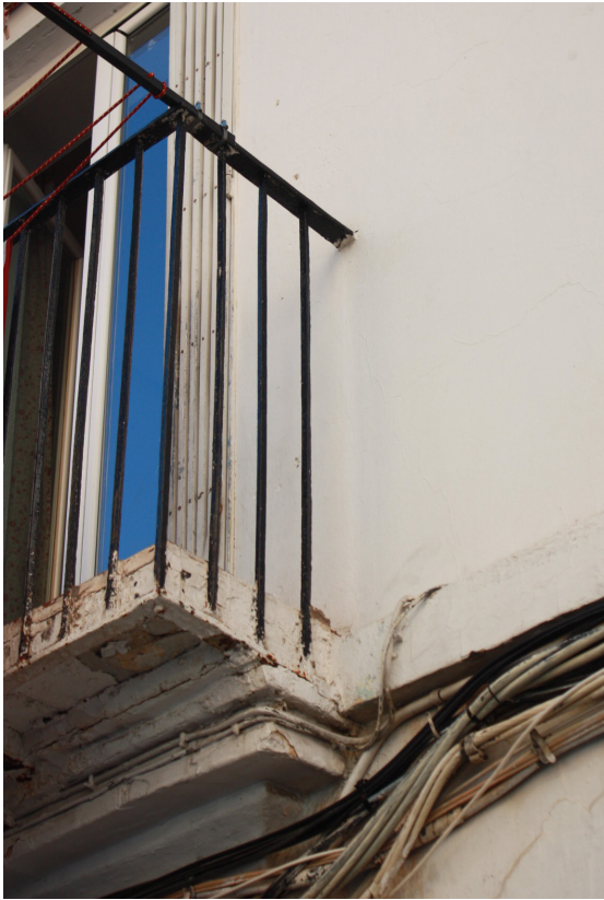
Figura 129. Balcón con estructura en jaula y sotabalcón cerámico. Calle Escalante. (Pastor, R. 2022)
