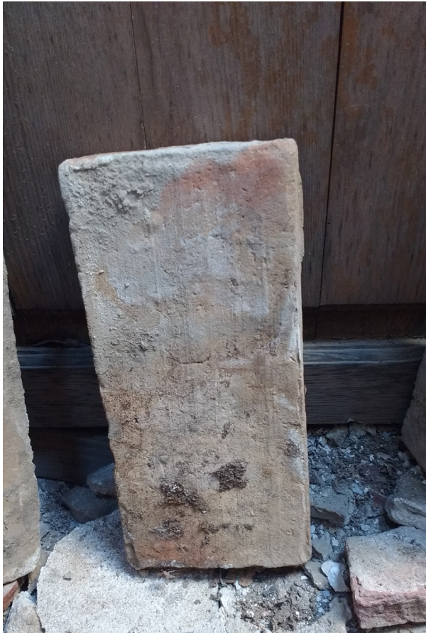
Figura 111. Ladrillo de fabricación manual utilizado para la formación de tableros de cubierta procedente de derribo vivienda. (Pastor, R. 2016)
