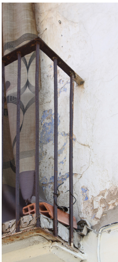
Figura 128.2. Detalle Barandilla de forja y estructura sotabalcón. Calle de los Ángeles (Pastor, R. 2011).
