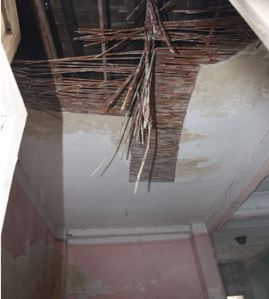
Figura 116. Vista del cañizo recubierto de yeso en interior vivienda. (Pastor, R. 2010)
