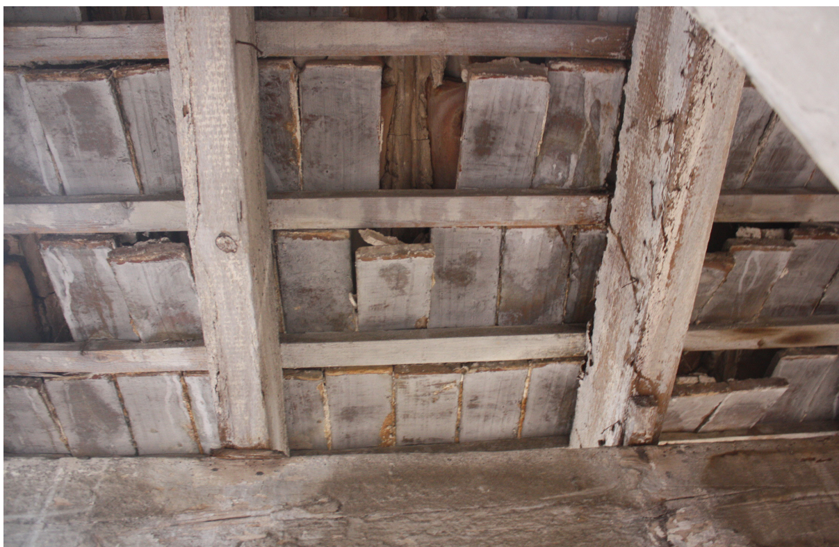
Figura 113. Detalle cubierta de teja sobre rasi-lla. (Pastor, R. 2016)
