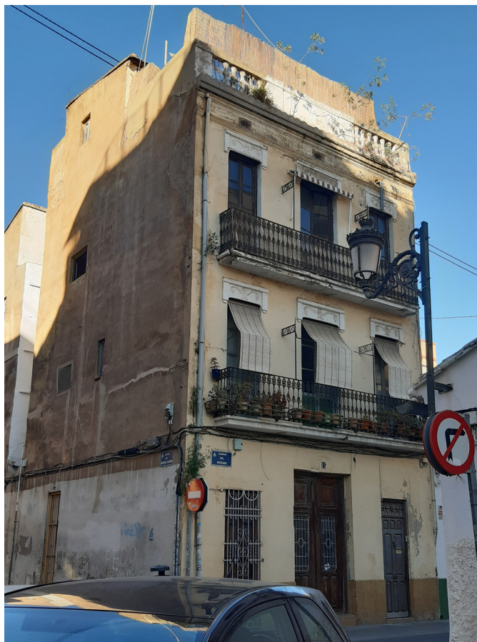
Figura 115. Edificio de viviendas con azotea transitable. (Pastor, R. 2022)
