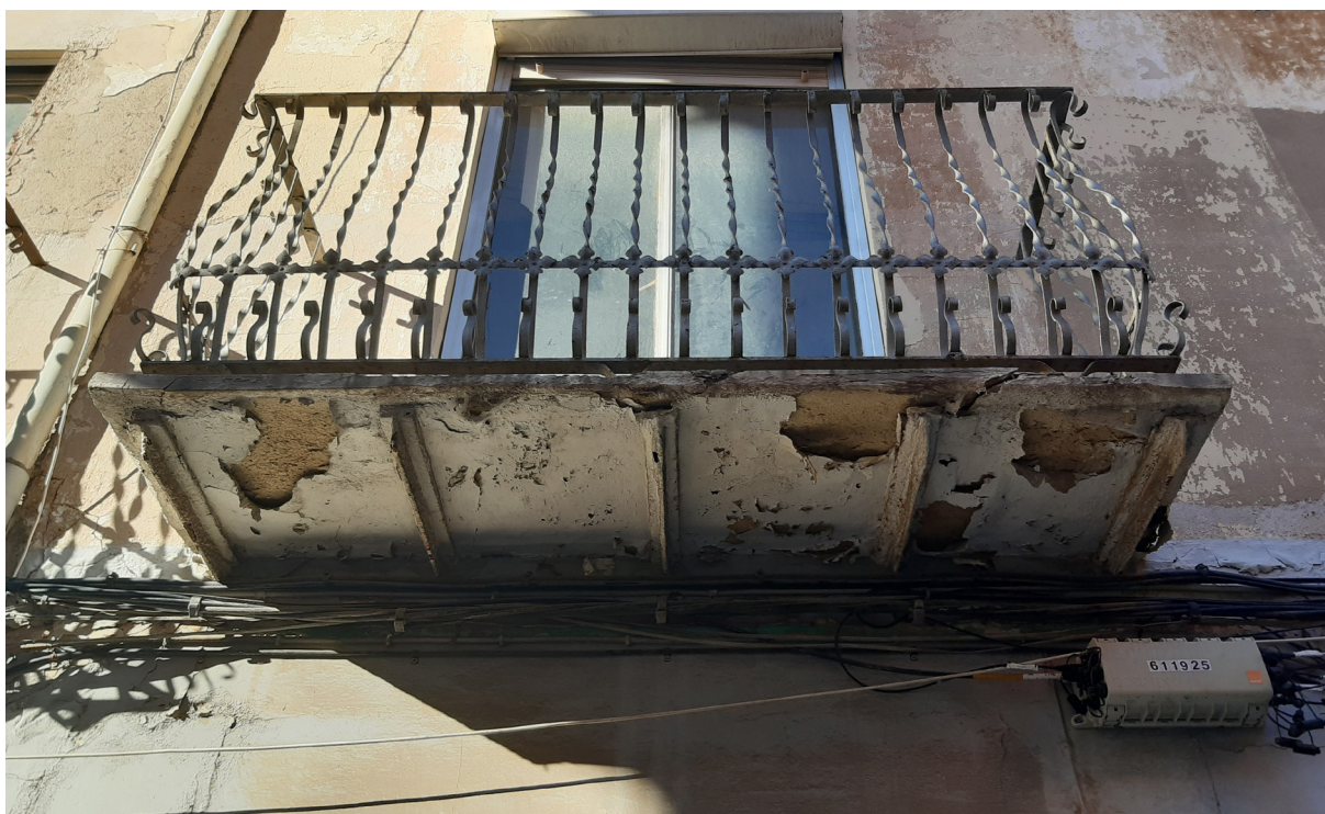
Figura 138. Estructura de balcón sobre perfiles metálicos. Calle Rosario. (Pastor, R., 2022)
