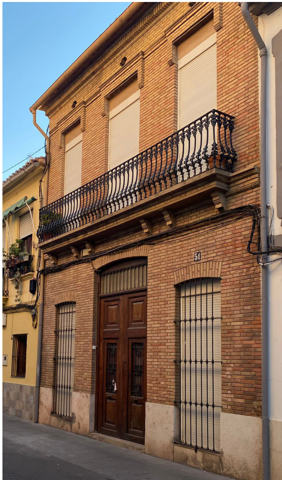
Figura 146. Dintel de ladrillo. Calle Rosario (Pastor, R. 2022)
