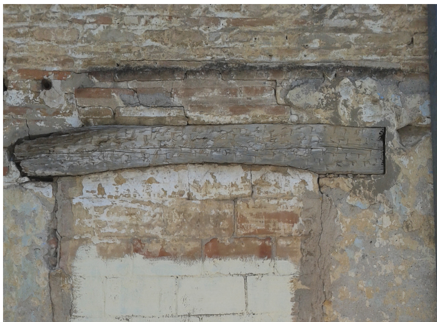
Figura 144. Dintel de madera. Calle Rosario. (Pastor, R., 2014)
