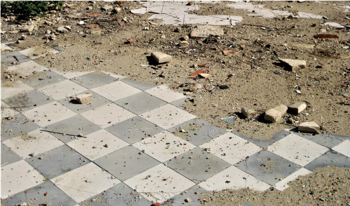
Figura 237. Restos de pavimento de baldosa hidráulica.
