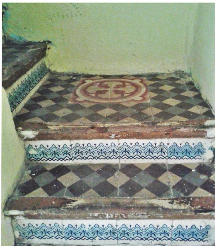
Figura 232. Contrahuellas revestidas material cerámico en calle Escalante (Pastor, R. 2015)
