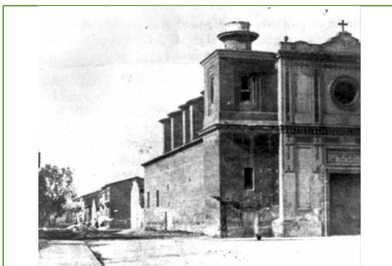
Arriba, detalle de la vidriera sobre el altar mayor (2022). Abajo, dos fotografías de la primitiva iglesia (1880) donde todavía se aprecia el faro demolido en 1925 (Col. Díaz Prosper y Rieta López).
