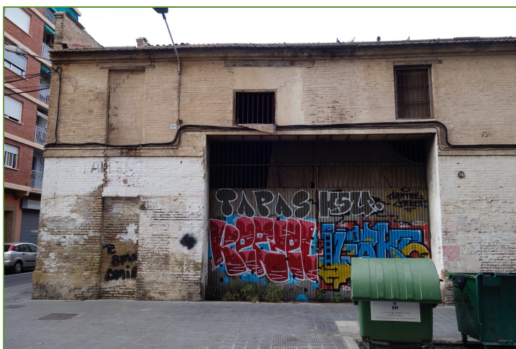
Vista de la fachada longitudinal, recayente en c/ Mariano Cuber (2018).
