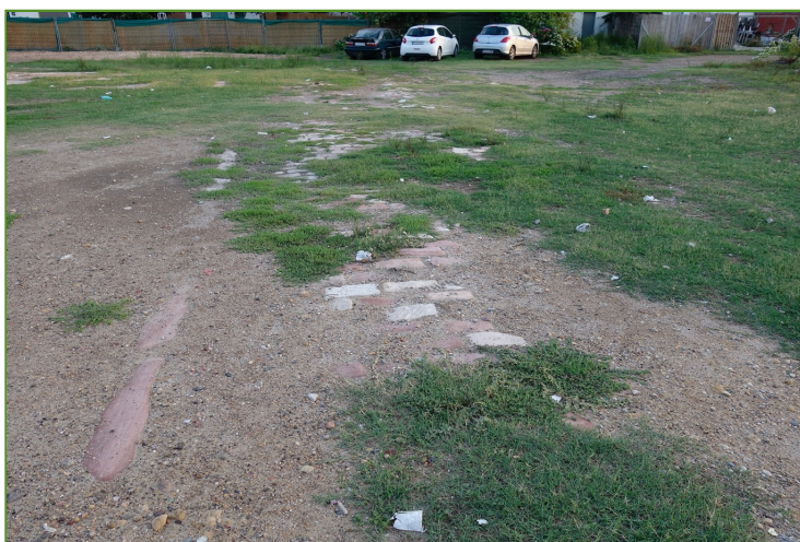
Imágenes de distintos tramos del viario, con detalle de los adoquines de rodeno (2018).
