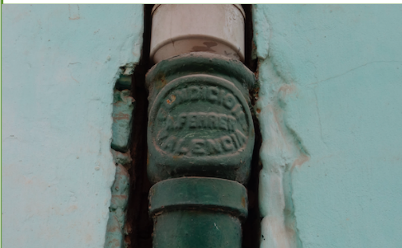
Marca de fundición (Fundación A. Ferrer Valencia) sobre bajante de desagüe. C/ Ramon Rocafull, 20 (2021).
