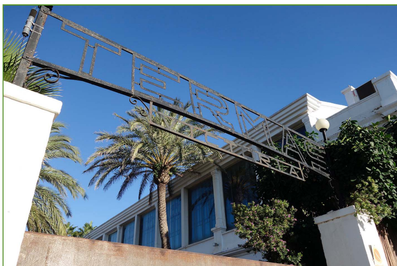
Arriba, vista de la fachada principal. En medio, escalinata doble de acceso. Sobre estas líneas, cartel de hierro colado con el nombre del establecimiento termal (2018).
