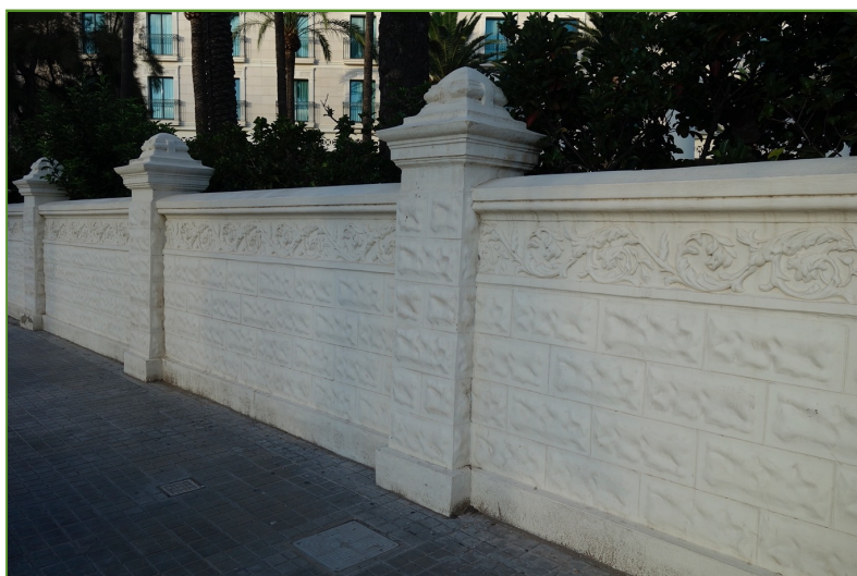
Arriba, distintas vistas del conjunto. Sobre estas líneas, tramo del muro perimetral (2018).
