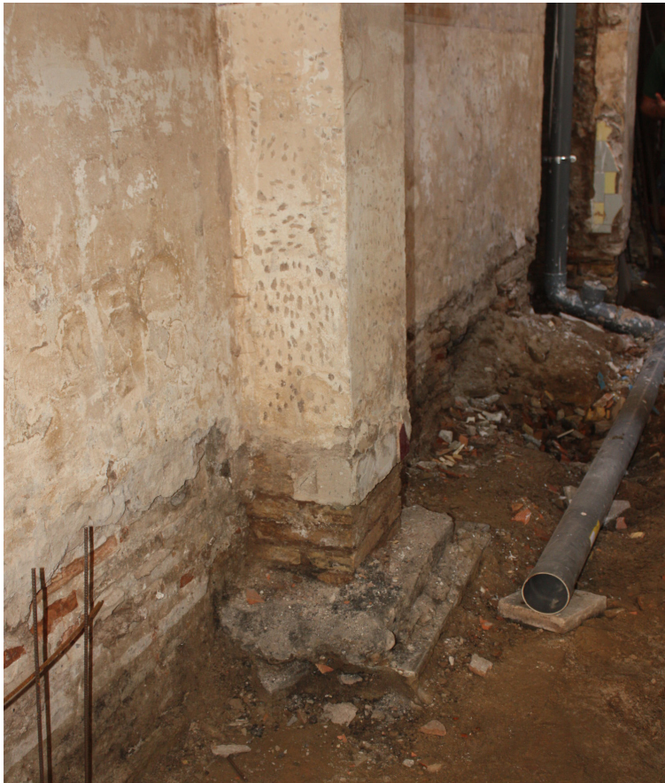
Figura 90. Detalle cimentación calle Padre Luis Navarro. (Pastor, R., 2016)
