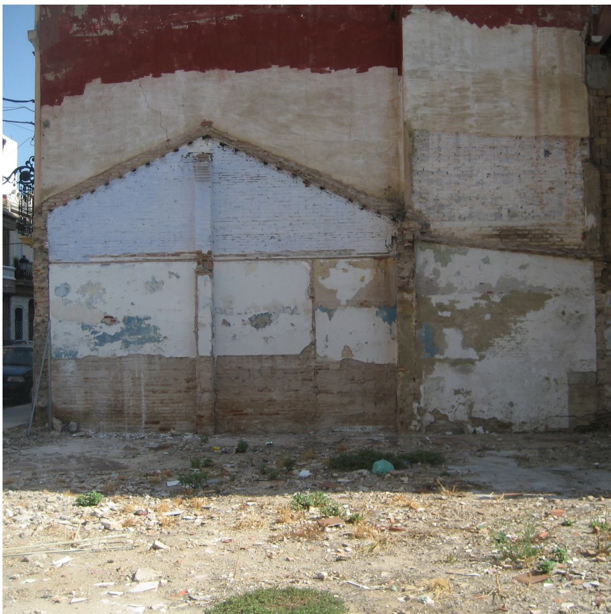
Figura 92. Sección de derribo en calle Escalante. (Pastor, R. 2011)
