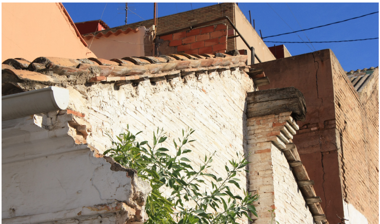
Figura 93. 2. Detalle pilastra y jácena de madera en Padre Luis Navarro. (Pastor, R. 2011)
