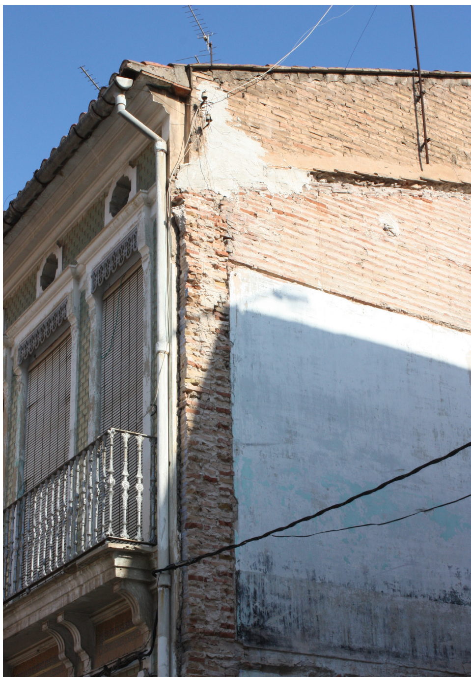
Figura 95. Muro de carga de fachada principal realizado con ladrillo macizo del edificio que estaba construido en calle San Pedro. (Pastor, R. 2011)
