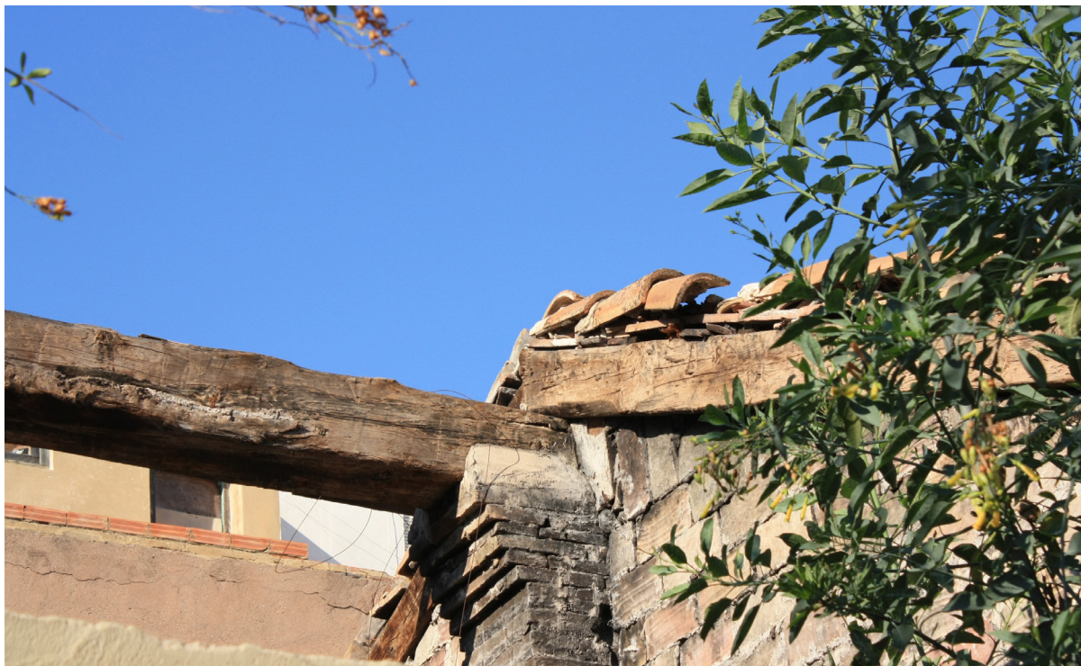
Figura 94. Detalle Pilastra y Jávena de madera en calle Progreso. (Pastor, R. 2011)
