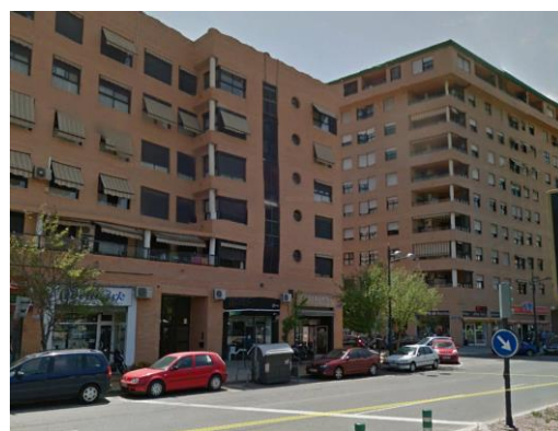
Edificios en Avda. Serrería
