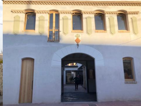
Tras la restauración
