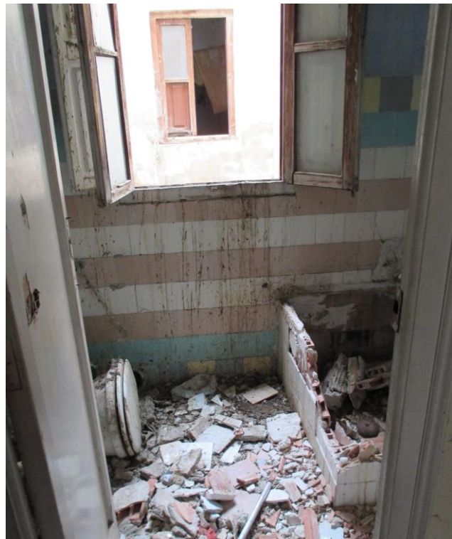
FOT-26 N° 3_Plaza Padre Domenech_Extensible al resto de edificios
