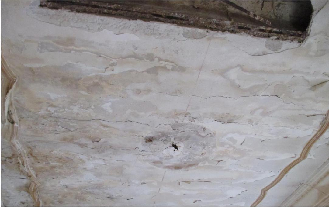
**FOT-31** N° 3\_Plaza Padre Domenech\_ Forjados de Cubierta atacados por Filtraciones de agua de Lluvia\_ Extensible al resto de edificios
