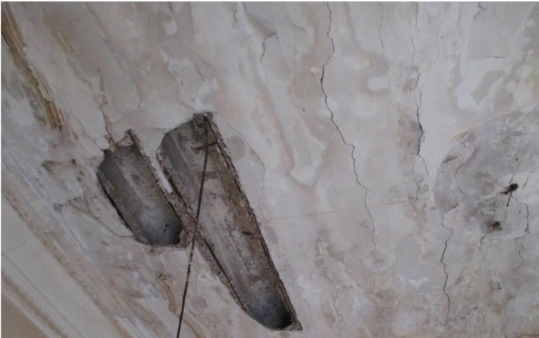
**FOT-30** N° 3\_Plaza Padre Domenech\_ Forjados de Cubierta atacados por Filtraciones de agua de Lluvia\_Extensible al resto de edificios
