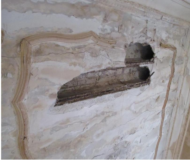
**FOT-29** N° 3\_Plaza Padre Domenech\_ Forjados de Cubierta atacados por Filtraciones de agua de Lluvia\_Extensible al resto de edificios
