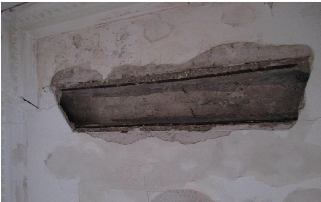
**FOT-28** N° 3\_Plaza Padre Domenech\_ Forjados de Cubierta atacados por Filtraciones de agua de Lluvia\_Extensible al resto de edificios
