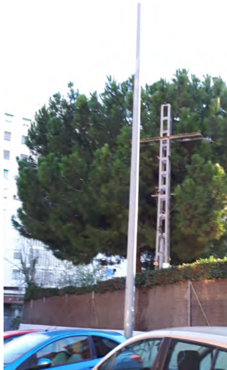
FOTO N°69: Poste eléctrico y arbolado dentro del colegio, esquina NE del mismo.
