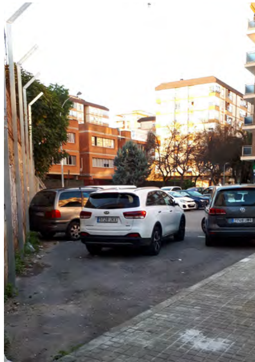
FOTO N°62: Cerramiento de edificación a demoler junto a zona de aparcamiento al Norte del Colegio Fomento Vilavella.
