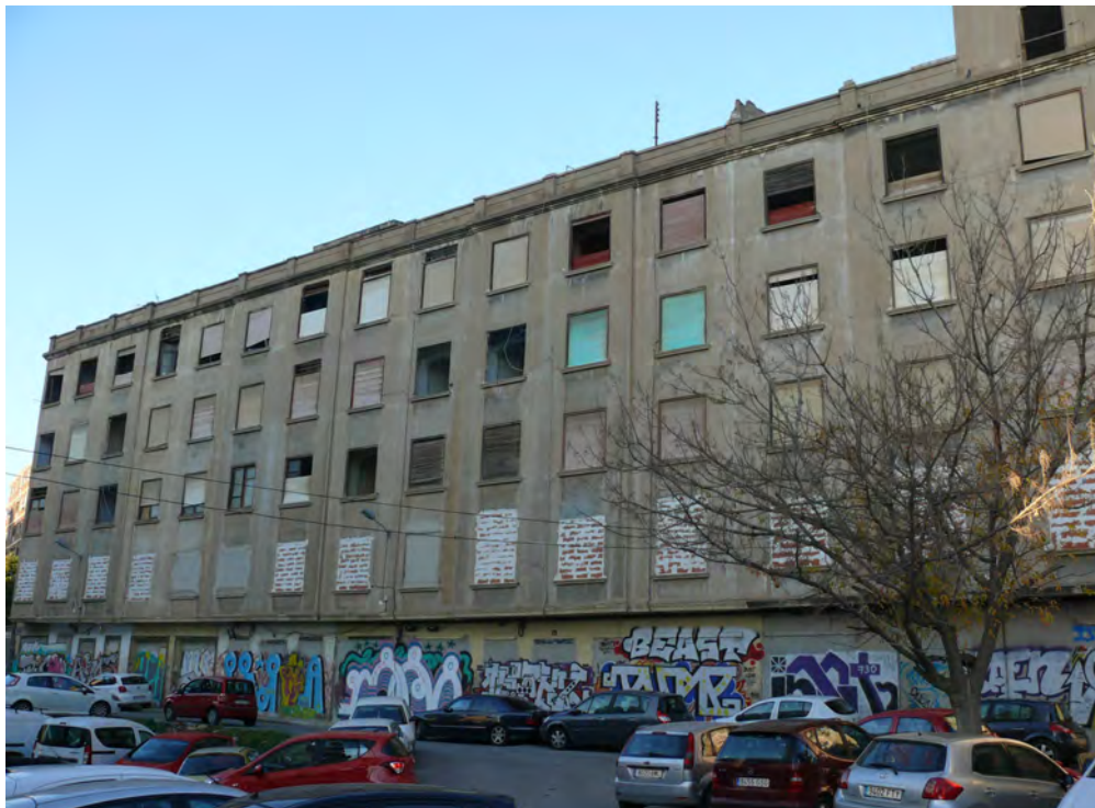
FOTO N°34: Edificación a demoler.
