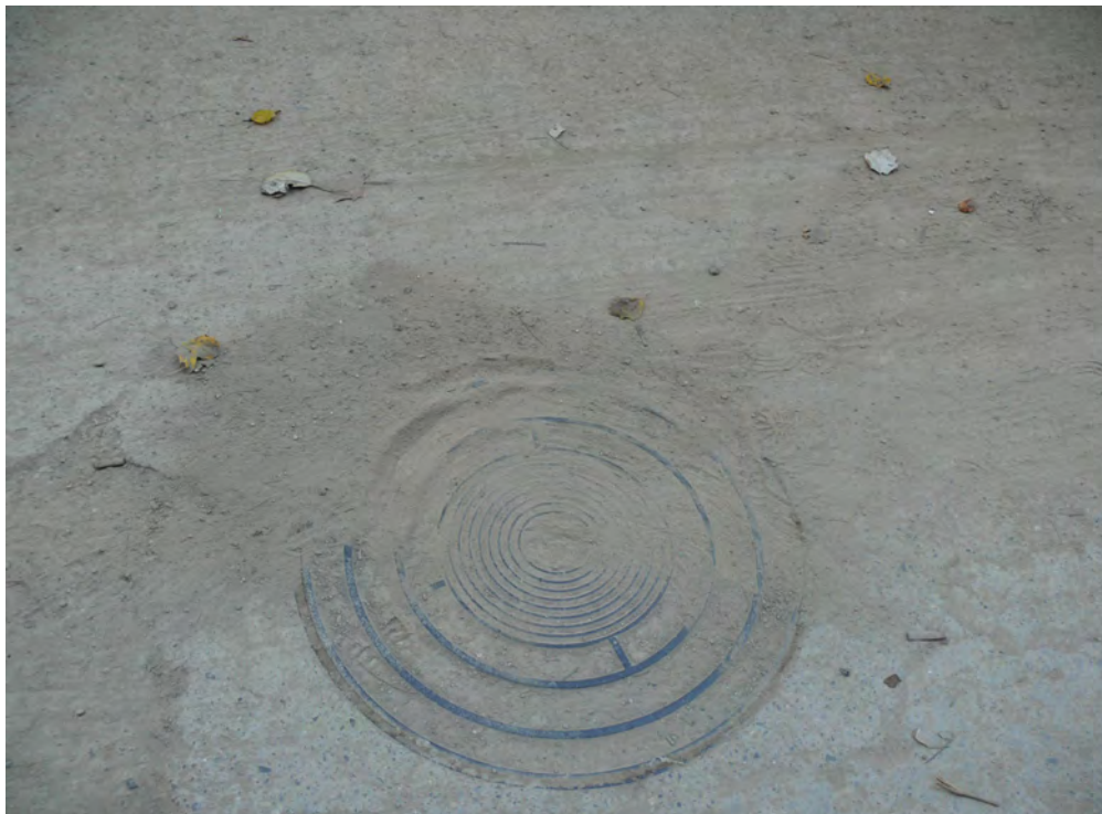
FOTO N°30: Pozo existente en viario entre el jardín del límite SE y la edificación existente fuera del ámbito.
