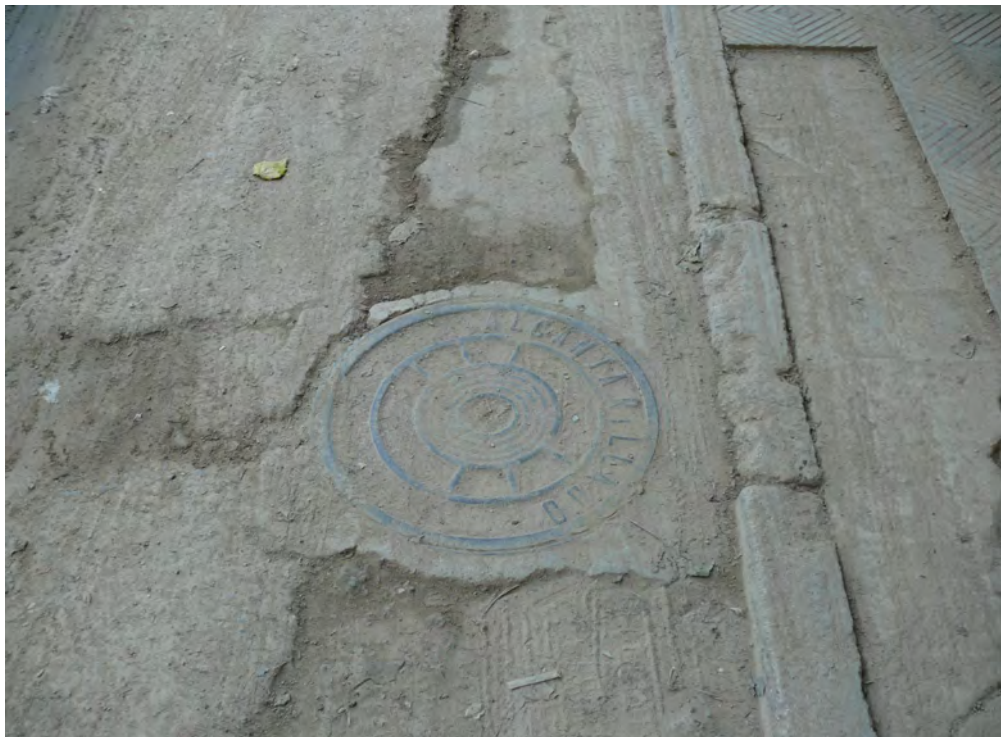
FOTO N°28: Pozo de saneamiento existente al límite SE. Junto a edificación.
