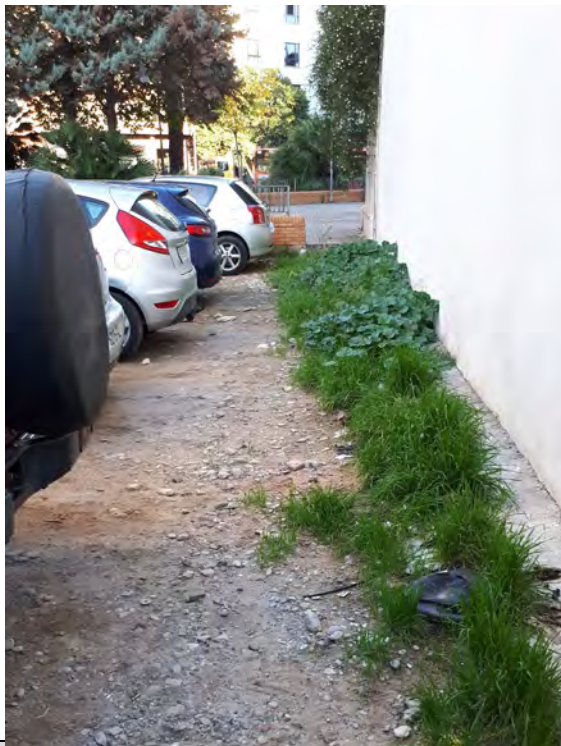
FOTO N°50: Borde de fachada de edificación desde la C/ Padre Domenech al Norte de la actuación.
