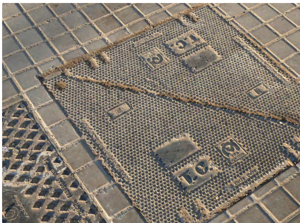
FOTO N°38: Arqueta existente en la Avda. Pio XII, fuera de la actuación..
