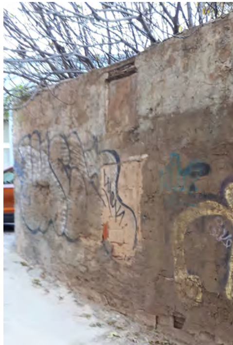
FOTO N°57: Muro de fábrica junto a la edificación a demoler. .
