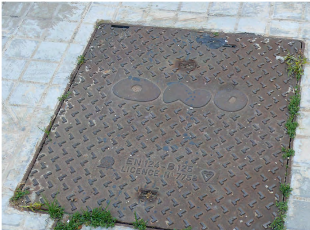
FOTO Nº4: Arqueta de Ono en la calle entre el colegio Fomento Vilavella y la Plaza Baden Powell.
