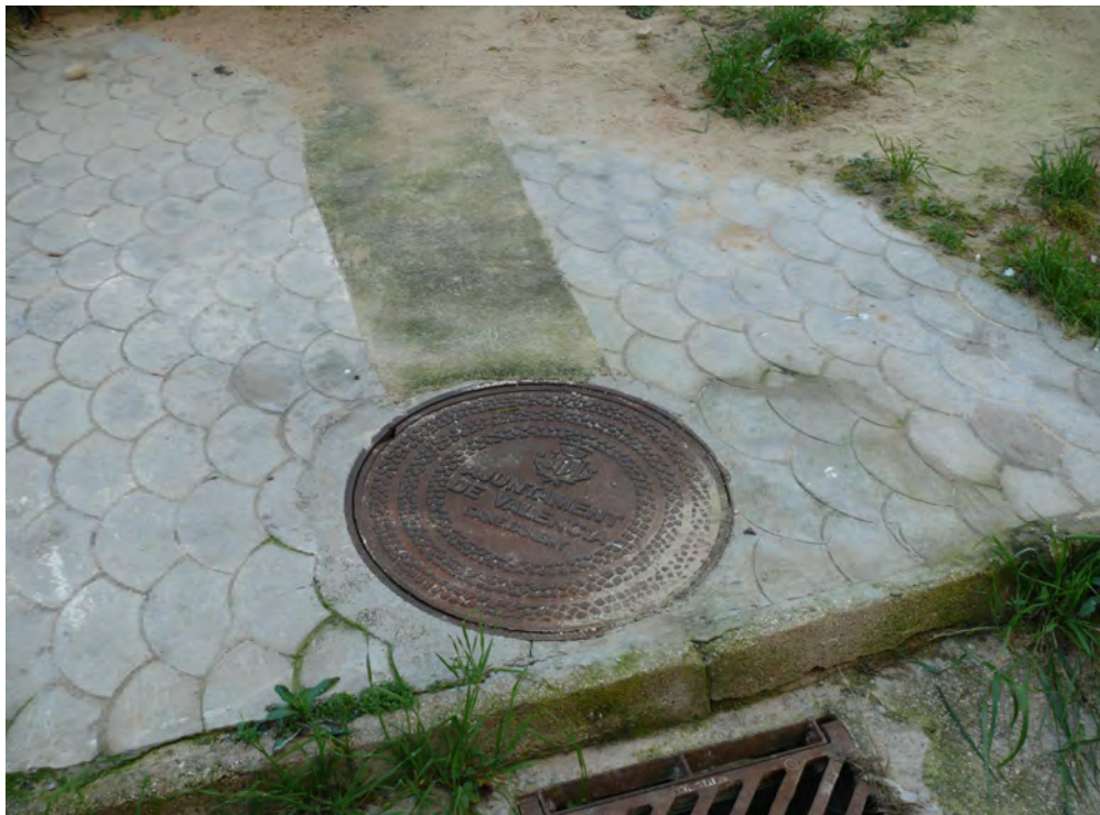
FOTO N°12: Pozo de saneamiento e imbornal existentes en el límite NO del PRI Plaza padre Domenech.
