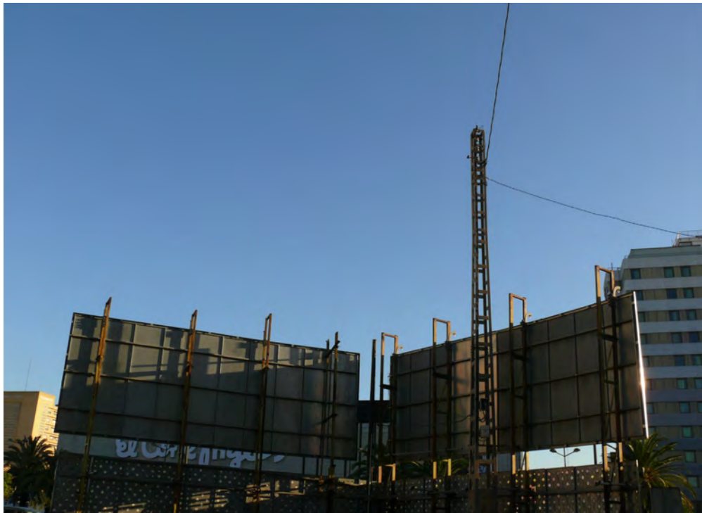
FOTO N°39: Poste eléctrico existente en el límite Este, junto a la Avda. Pio XII. Carteles dentro del ámbito. .
