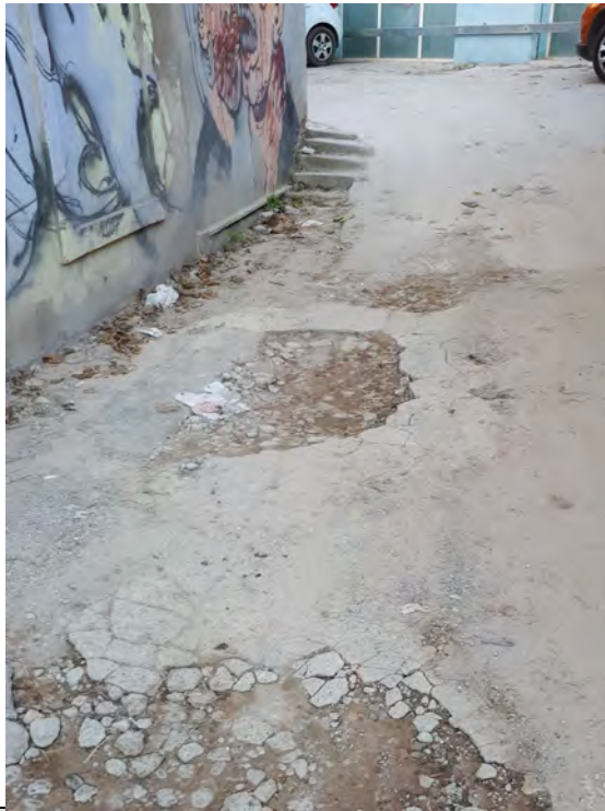
FOTO N°56: Escaleras existentes y viario que bordea edificación a demoler.
