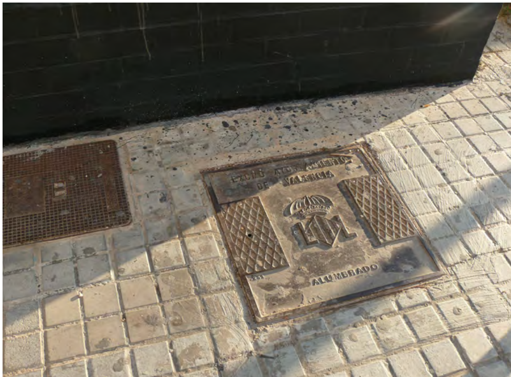
FOTO N°16: Arquetas en acera del límite SE de la actuación.
