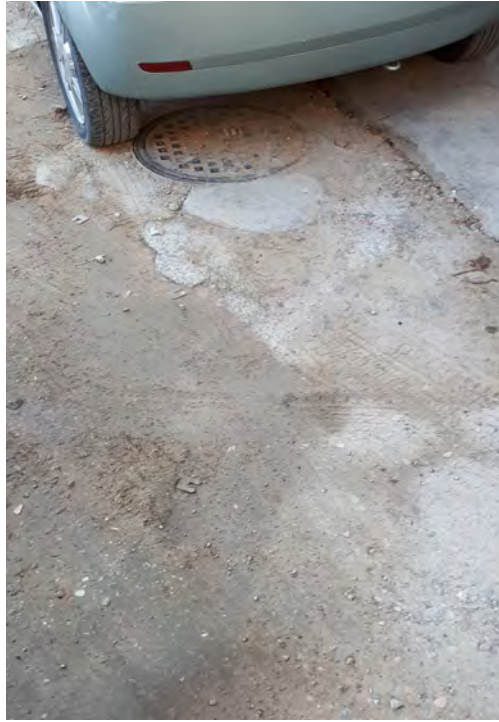
FOTO N°55: Pozo existente en borde de edificación a demoler .
