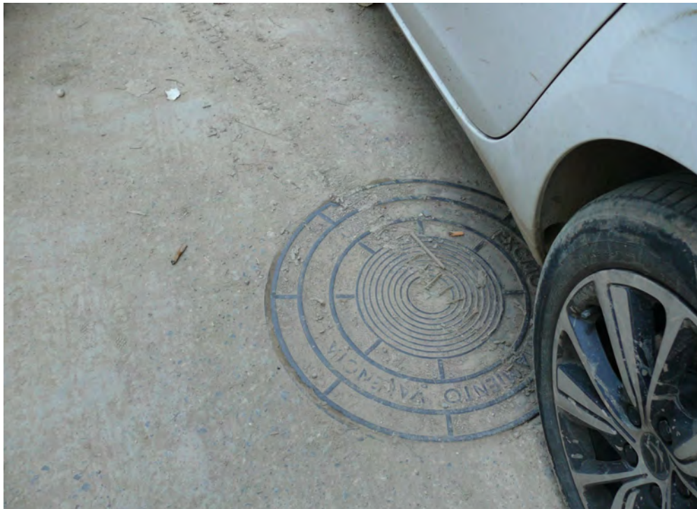
FOTO N°31: Pozo existente en viario entre el jardín del límite SE y la edificación existente fuera del ámbito.
