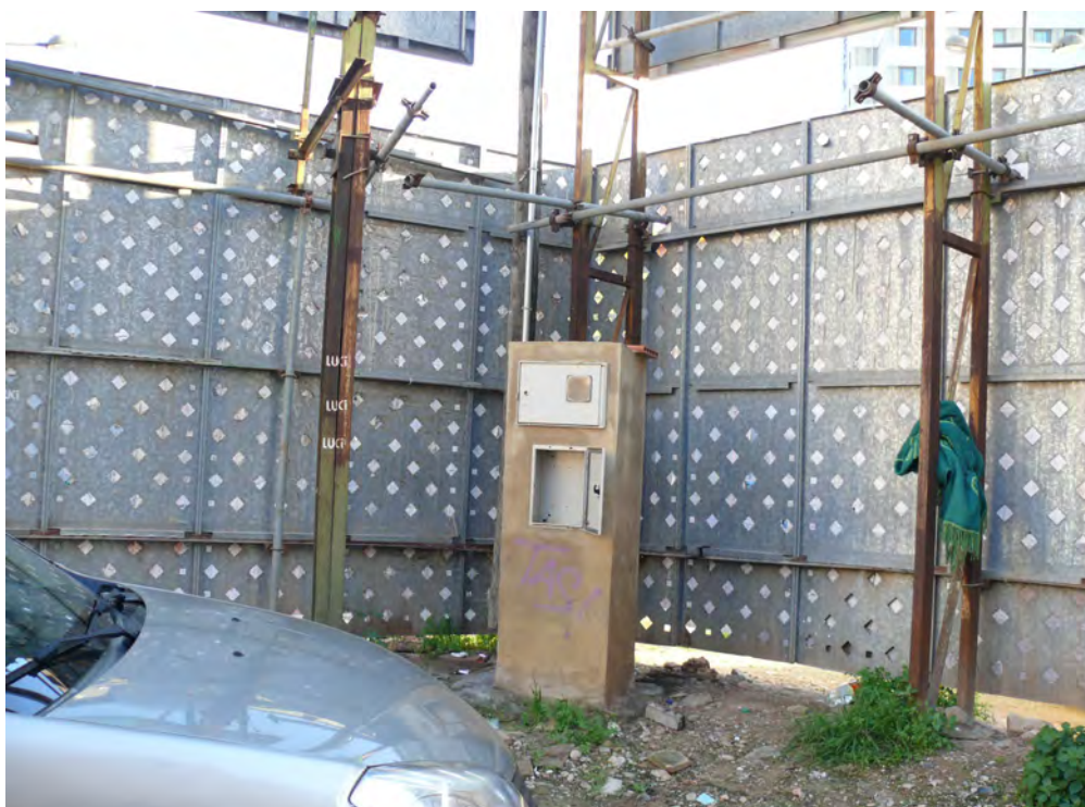
FOTO N°40: Detalles de cartelería y armario junto al poste eléctrico de la foto n° 39..
