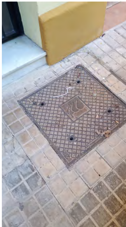
FOTO N°48: Arqueta de gas en acera de C/ Padre Domenech, al Norte de la actuación.
