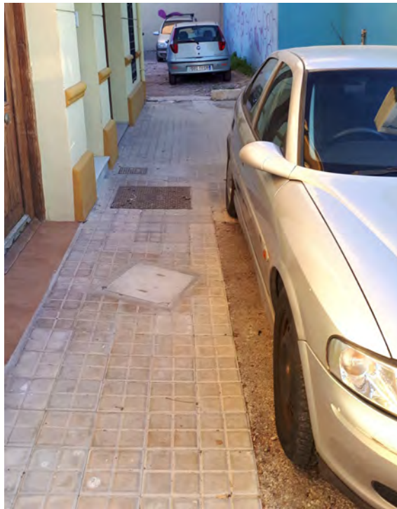
FOTO N°47: Vista de acera y arquetas existentes en C/ Padre Domenech.
