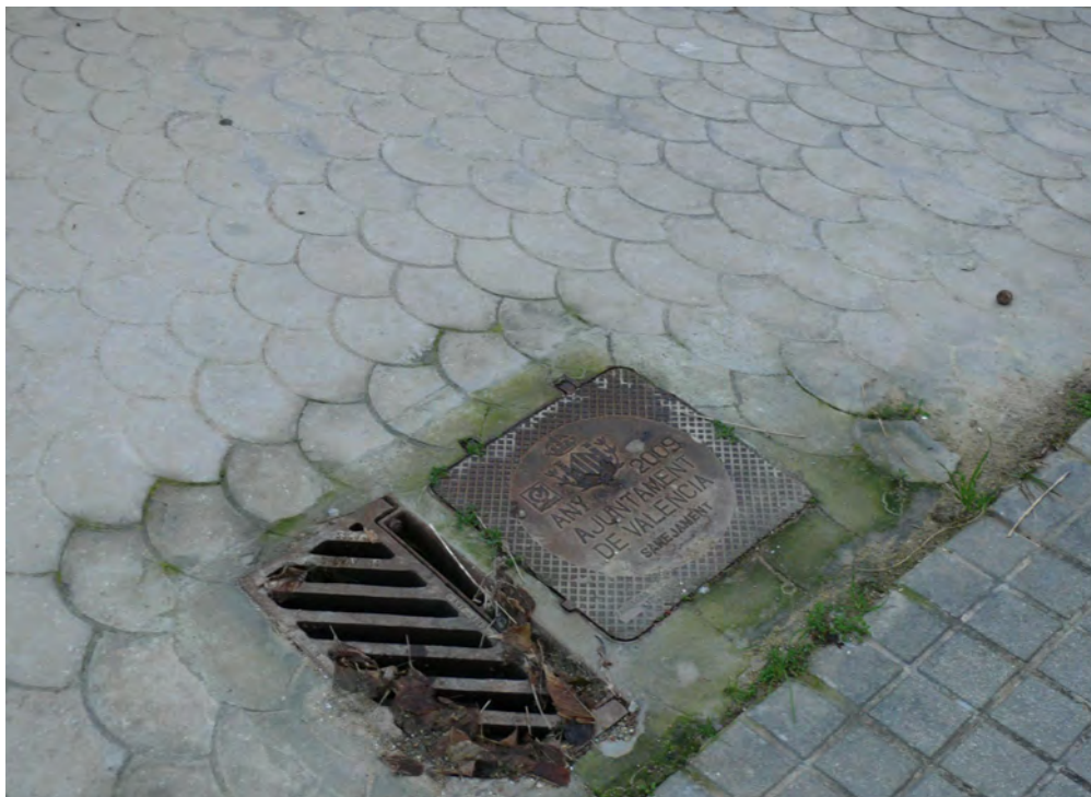
FOTO N°11: Imbornal sumidero en calle peatonal al limite sur del colegio Fomento Vilavella.
