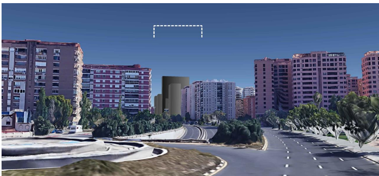
Ordenación propuesta (planeamiento modificado). Vista panorámica desde la entrada norte (Torre Mirador).
