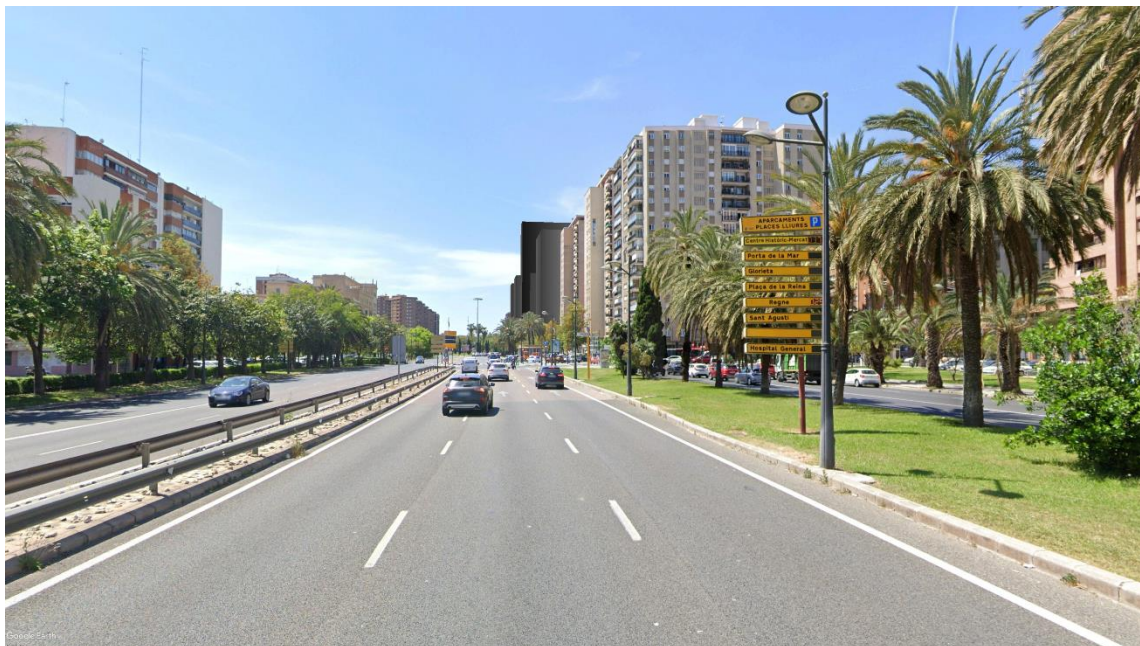
Vista desde la Avenida de Cataluña (salida del túnel).
